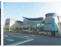
公共車站 閘門溫度偵測
